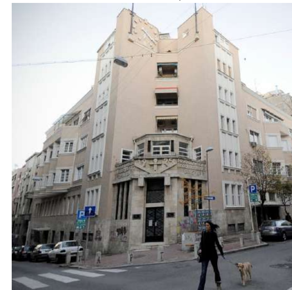
Aleksandar Pop i Stevan Tobolar Zgrada Parobroda
